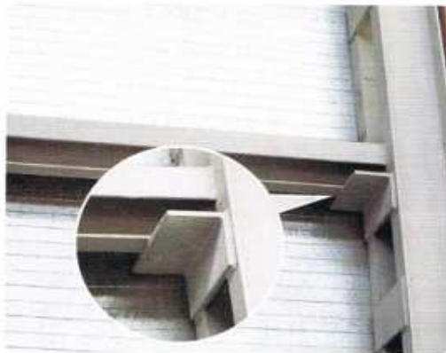
Los perfiles de acero se unen mediante soldadura, incorporando piezas de refuerzo para dar rigidez a la unión.
